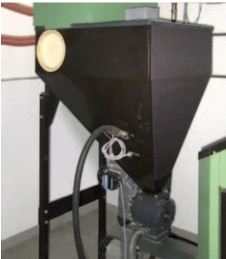
Recipientul intermediar al sistemului HDG de aspirație peleți are o capacitate de până la 100 kg.
